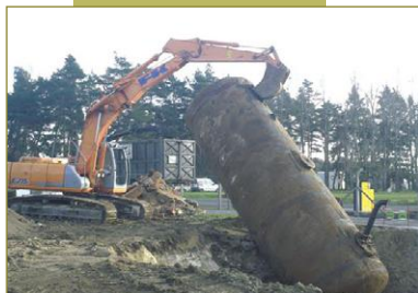
Démantèlement de cuve hydrocarbure
