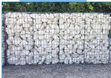
Exemple de gabion de 2 m x 0,5 m x 1 m
