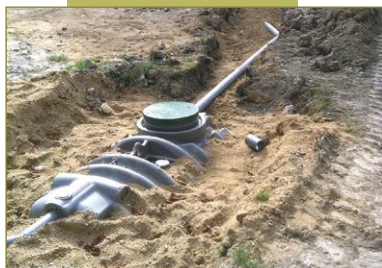
Mise en œuvre d'une fosse toutes eaux
